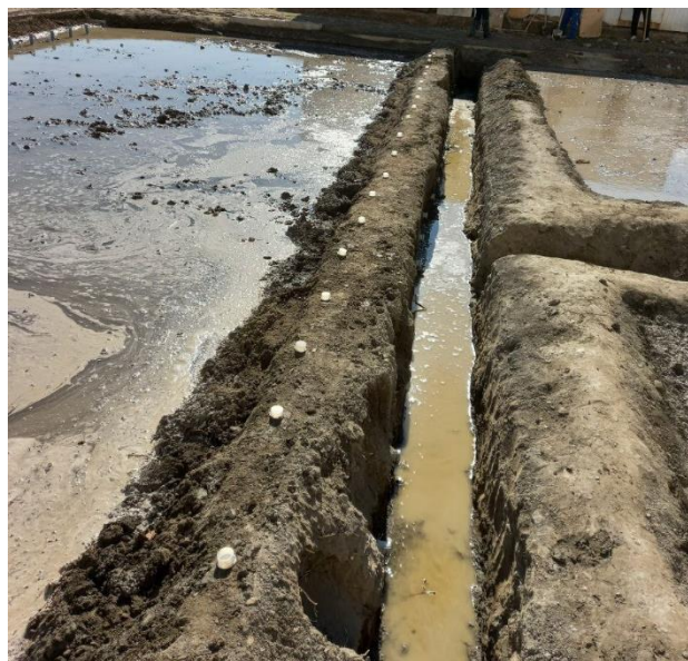
5-rasm. Drenaj quvurlari yordamida shoʻrni yuvish jarayoni
